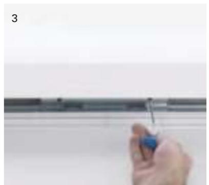
1 - Inserimento del giunto meccanico fra i moduli strutturali
